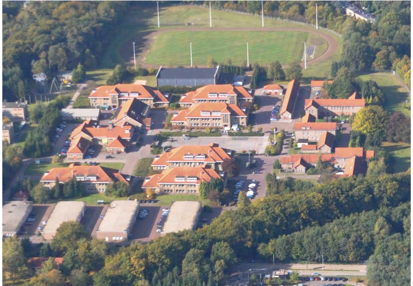
luchtfoto Elias Beekman complex
