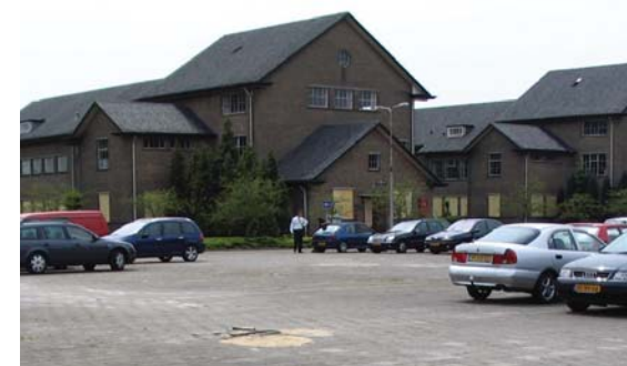
Bestaande kazernecomplexen hebben een heldere ritmiek en staan haaks op het defileerterrein
