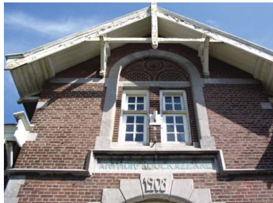
Bijzondere afwerking van de kapconstructie op de koppen
