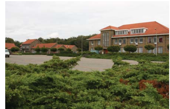
Groene taluds omkaderen het Defileerterrein
