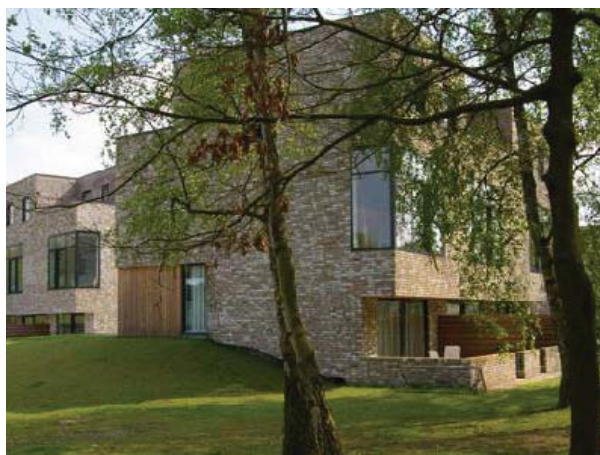
Hoogteverschillen worden in beeld gebracht
