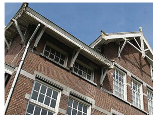
Overstek als kenmerkend element van de kazernecomplexen
